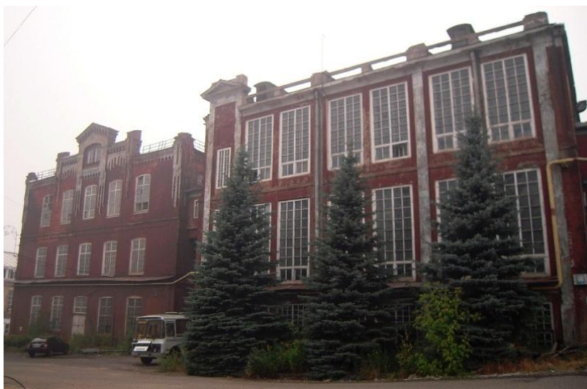
Фото 1. Вид со стороны проспекта Ленина
