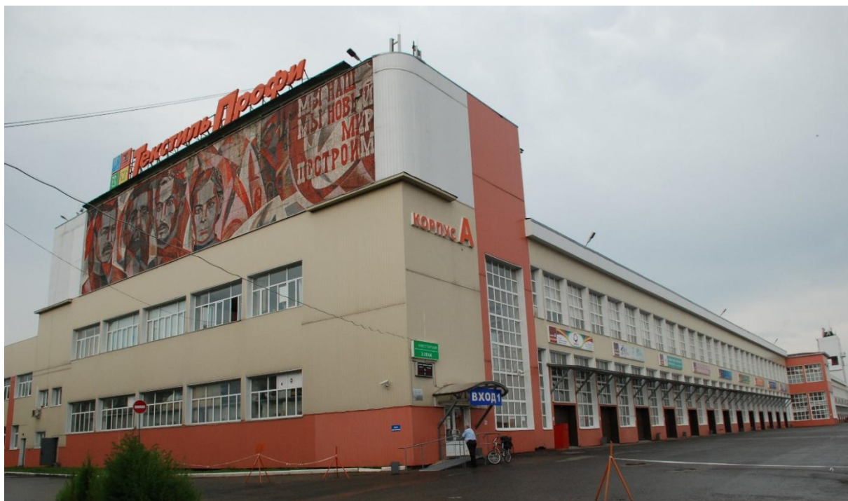
Рис.3. Мозаичное панно «Героям революции» на здании прядильного производства фабрики «Красная Талка» (по состоянию на 2017 г.)
