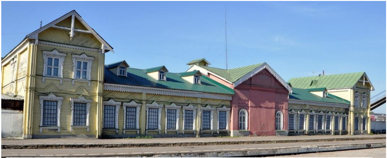
Рис. 1. Современное фото. Фасад со стороны путей
