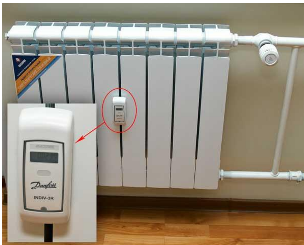
Рис. 1. Отопительный прибор с теплосчетчиком и регулятором температуры
