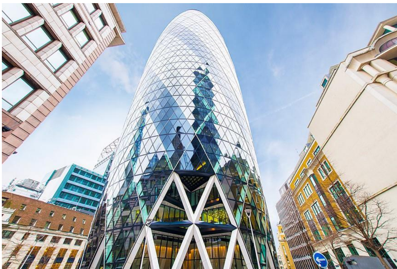
Рисунок 8 – Башня Мэри-Экс, Лондон [106]
