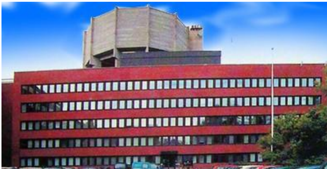
Рисунок 2 – Энергоэффективное здание «EKOONO-house» (Финляндия, Отаниеми, 1973 г.) [112]
